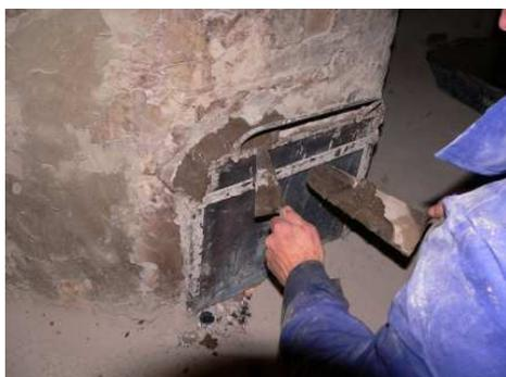
Fig. 21. Sigillatura sportello caldaia.
